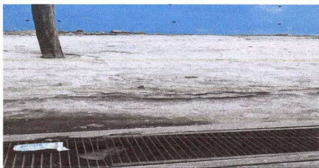
Foto 3: Reparación de planchas de concreto de patio
