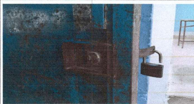
Foto 2: Sustitución de chapa
