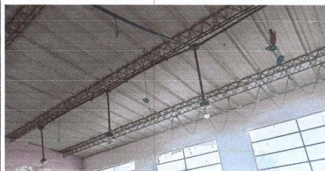
Foto 4: Sustitución de focos ahorradores + Sustitución interruptores dobles
